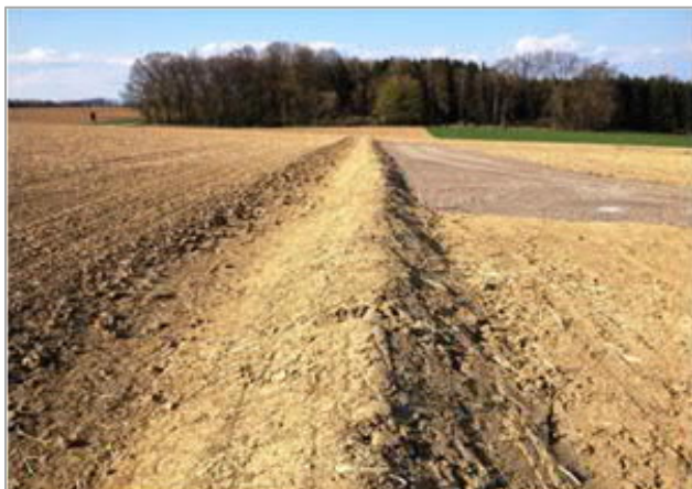
Abbildung 21: Kleiner Erddamm zur gezielten Umleitung von Hangwässer
