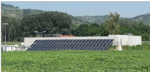
Abbildung 32: Rückhaltebecken Mautern mit PV-Anlage
