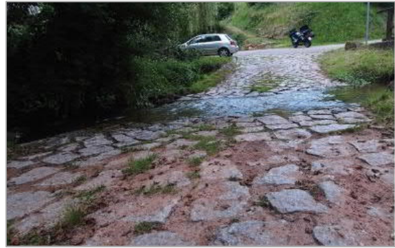
Abbildung 23 und 24: Umbau eines verklauungsgefährdeten Durchlasses in eine verklauungsfreie Furt
