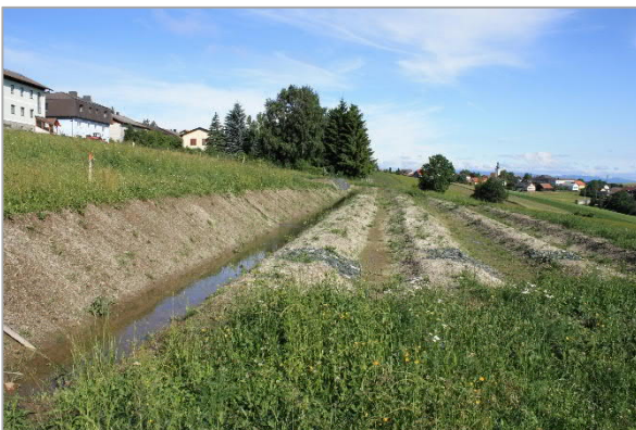
Abbildung 25: kaskadenförmige Sickersmulden, kurz nach deren Fertigstellung
