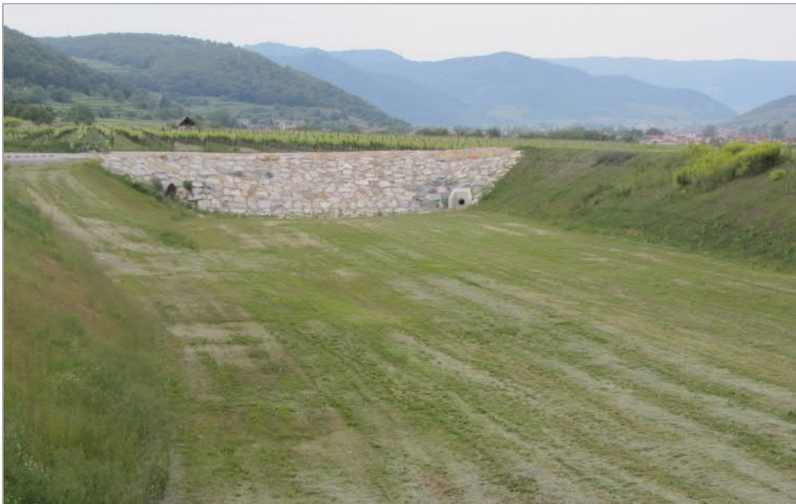
Abbildung 40: Rückhaltebecken Mautern Weinbergstraße kurz nach Fertigstellung
