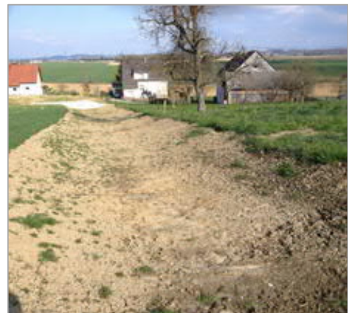
Abbildung 22: Breit angelegte Mulde für eine kontrollierte Ableitung
