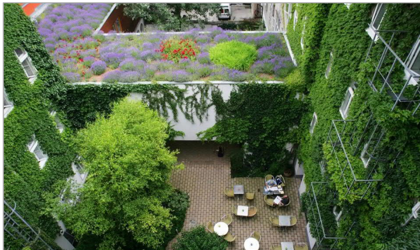
Abbildung 18: Ansicht Fassadenbegrünung und Gründach
