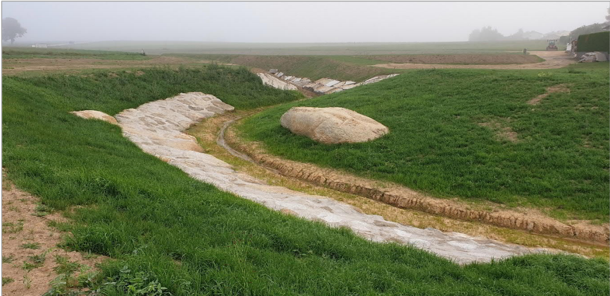
Abbildung 17: Notüberlauf eines Rückhaltebeckens
