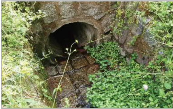
Abbildung 23 und 24: Umbau eines verklauungsgefährdeten Durchlasses in eine verklauungsfreie Furt
