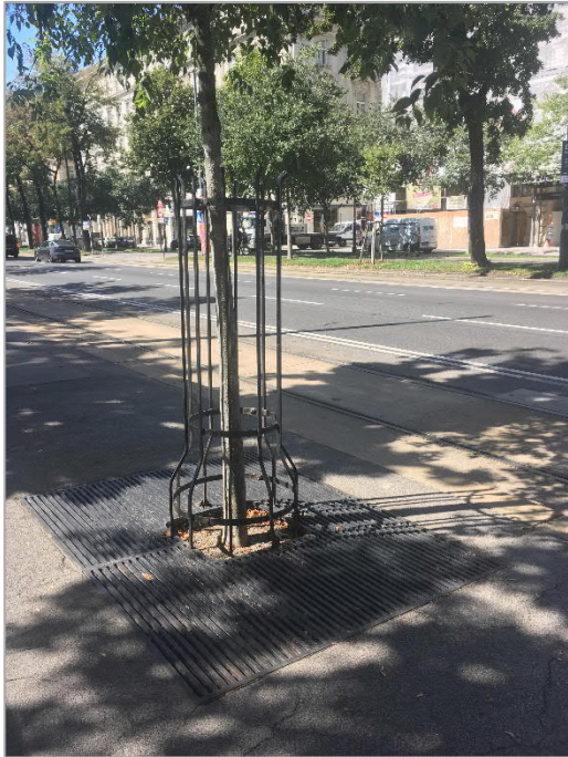
Abbildung 14: Baumscheiben mit großem durchwurzelbarem Retentionsraum
